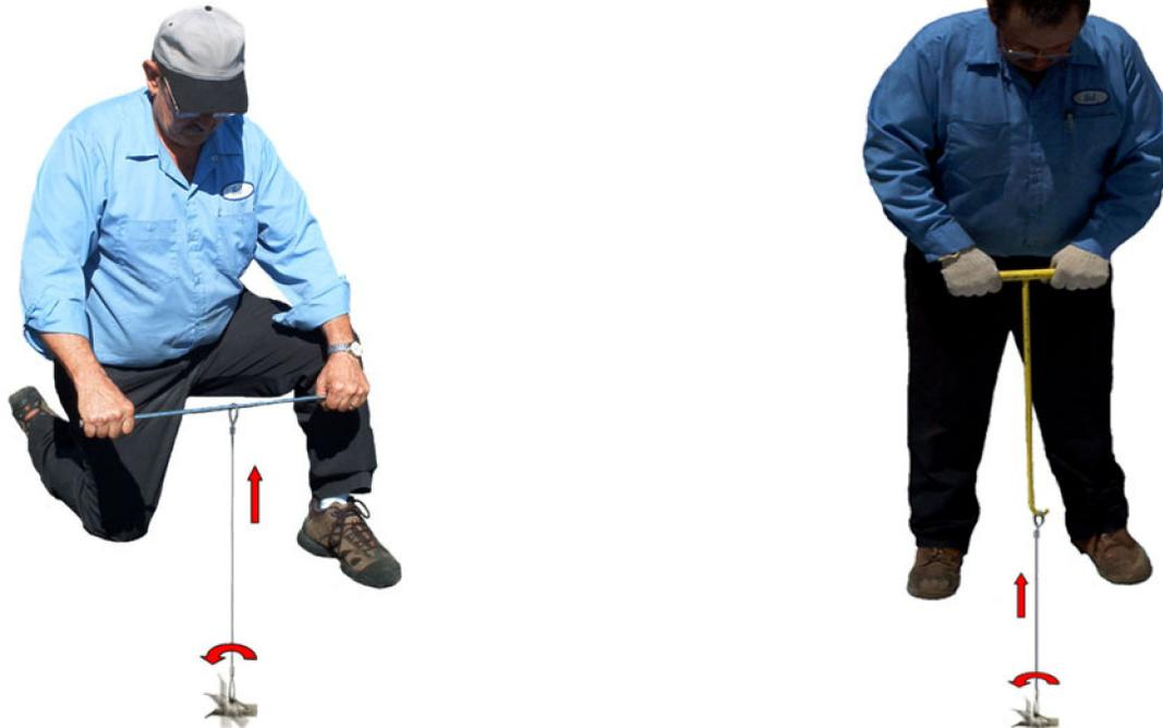
Закрепление анкера с использованием стального толкателя
